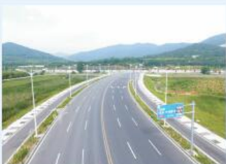
襄阳市滨江路东延段新建工程c标（金奖） 施工单位：襄阳路桥市政（集团）工程处 监理单位：武汉江南工程建设监理有限公司 乐精明 摄
