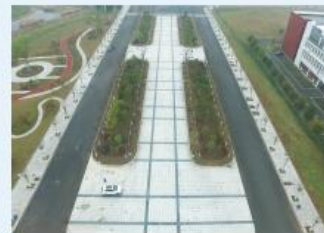
宜昌市职教园区道路二期工程 施工单位：湖北益通建设股份有限公司 监理单位：宜昌市虹源公路工程咨询监理有限责任公司 湖北益通 供稿
