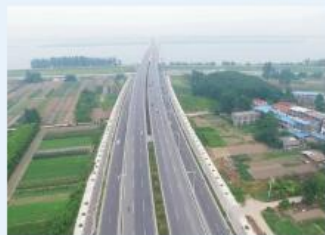
襄阳市滨江路东延段新建工程 （子项：滨江路与内环线连接段） 施工单位：襄阳路桥市政（集团）工程处 监理单位：中国轻工业武汉设计工程有限责任公司
