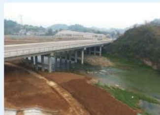
宜昌市五龙三路（将军路—卷桥河一路）市政工程（银奖） 施工单位：湖北益通建设股份有限公司 监理单位：武汉威仕工程监理有限公司 湖北益通 供稿
