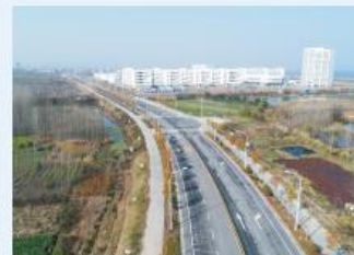
武穴市东城区16号路（20#路至江大道）建设项目（银奖） 施工单位：湖北振天建筑工程有限公司 监理单位：湖北东展工程监理有限责任公司 何建华 摄
