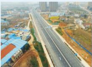
武汉江汉六桥汉阳接线一期工程（郭琴路—汉阳大道段） 施工单位：中建三局中建三局三公司 监理单位：中铁武汉大桥工程咨询监理有限公司 阮文波 摄
