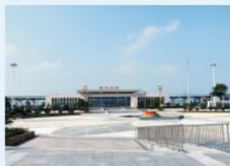
枝江市火车站站前广场二、三期工程 施工单位：湖北恒诚建设有限公司 监理单位：宜昌智强建设工程技术咨询有限公司 宜昌宏业工程项目管理有限公司 杨海露 摄
